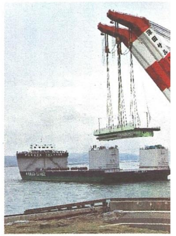
桁撤去台船積み込み状況
