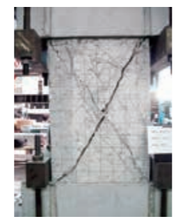
6 せん断破壊試験後状況(補修後) ※せん断破壊は注入位置ではなく、オリジナルコンクリート部で発生
