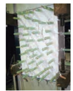
3 エポキシ樹脂注入状況 使用材料: E-396H IPHカプセル: 注入圧力0.06N/mm 2
