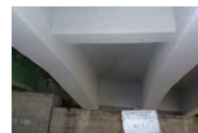
5 完成 (橋梁下部)
