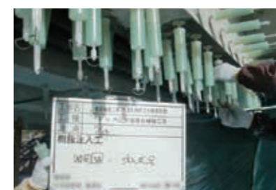
4 注入硬化養生 (IPHカプセル)
